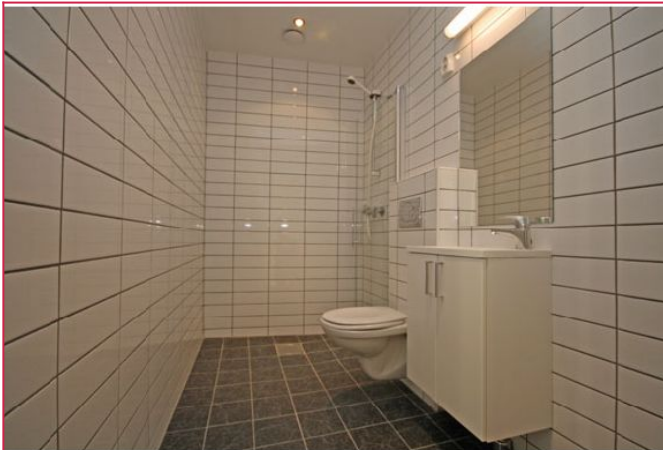
Bad med varmekabler i gulv og opplegg til vaskemaskin.
