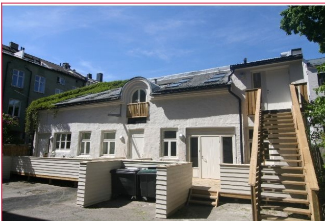
Stallbygning i bakgård. Leiligheten blir til høyre i bildet, 1. etg.
