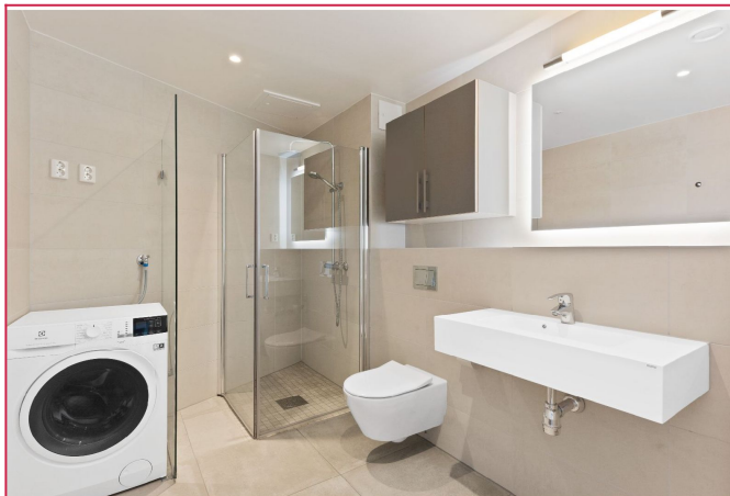
Baderom med opplegg for vaskemaskin
