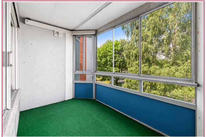
Innglasset balkong uten innsyn
