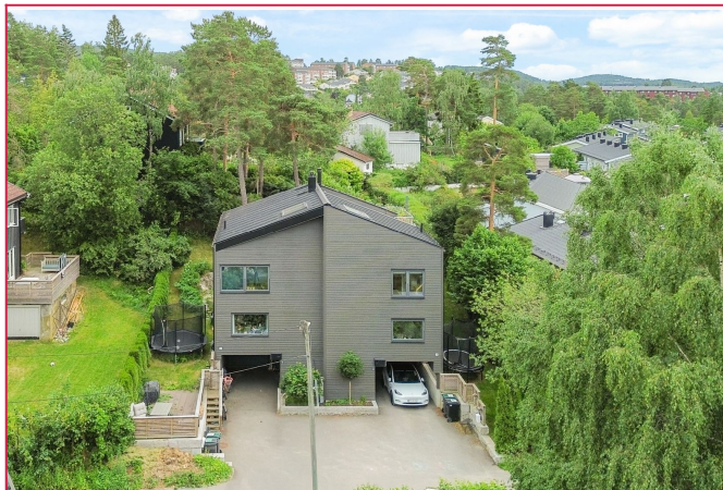
Fasade. Boligen har carport med el-lader.
