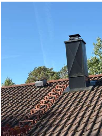
Pipebeslag, luftehatt nentilasjon og takstige
