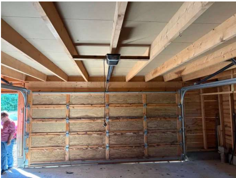
port i trepanel med portåpner
