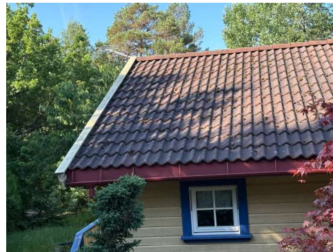
takrenne med fotbeslag og overkroker
