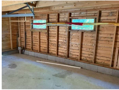
ytttervegger uisolert
