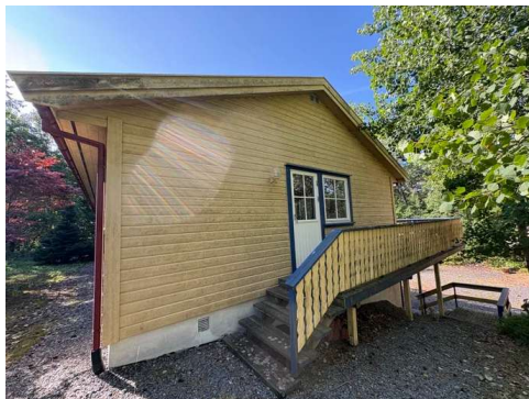
Nedløp tilkopleet rør i grunn
