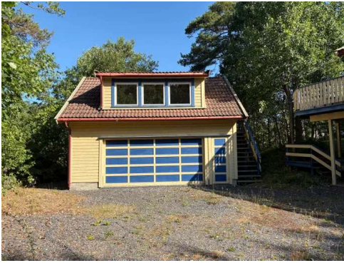
fasade mot tun
