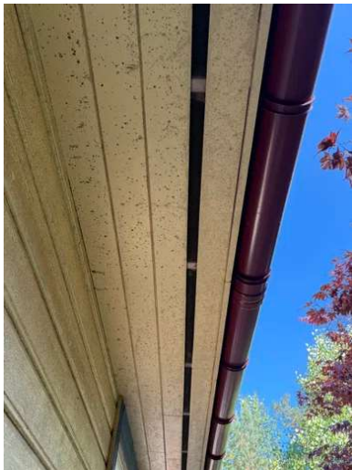
takrenne med fotbeslag og overkroker
