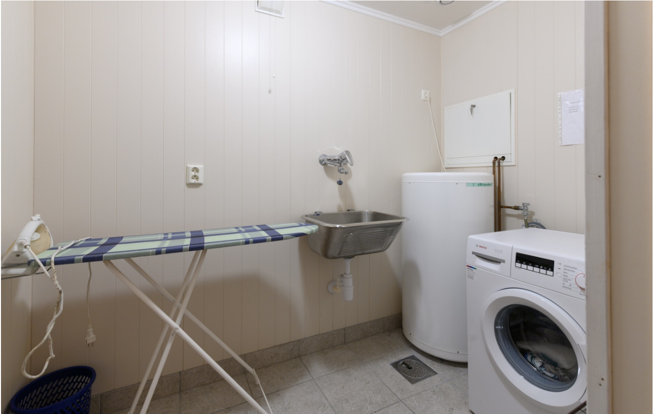
Vaskerom / teknisk rom
