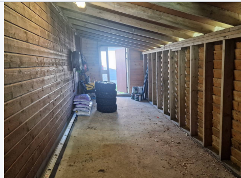
Hellende gulv, åpent mellom sperrer
