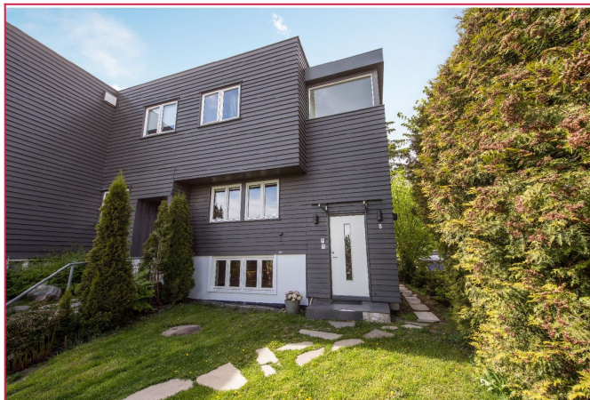
Utvendig fasade og inngangsparti.
