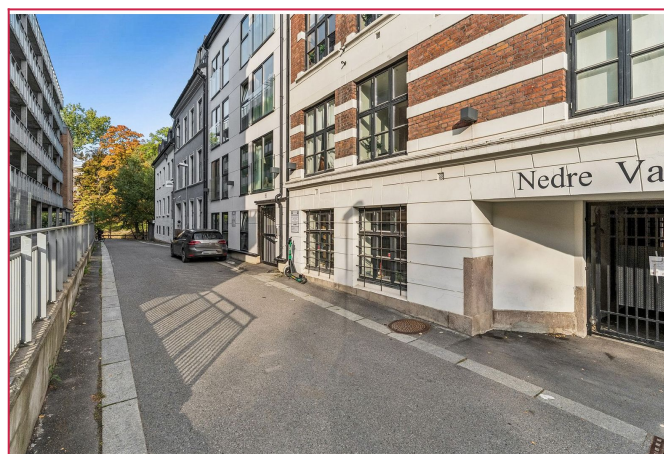
Fasade og inngang til bygget
