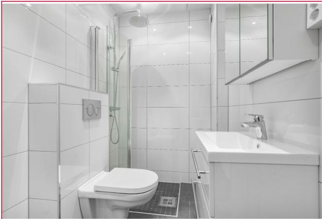
Bad med varmekabler og opplegg til vaskemaskin.
