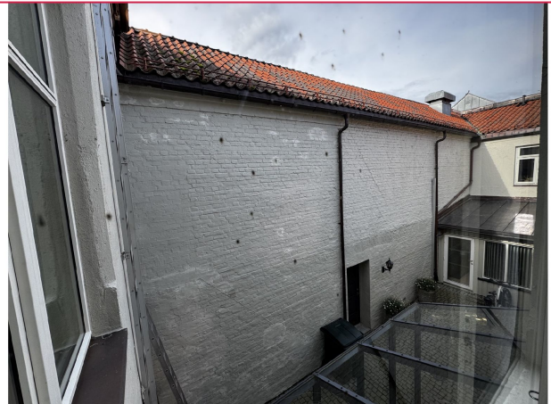
Vinduer vender mot rolig bakgård.
