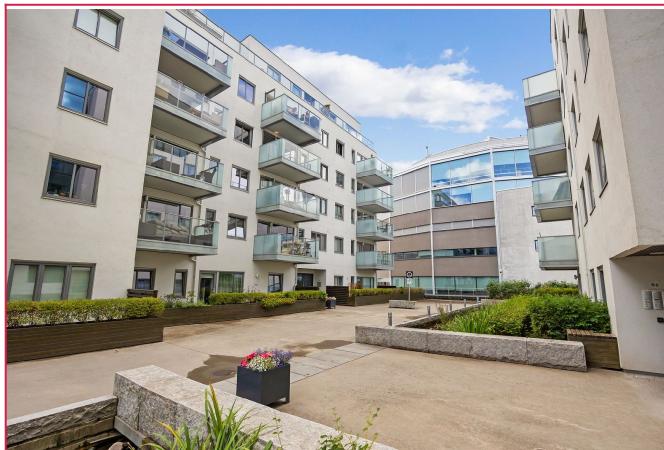
Pent opparbeidet gårdsrom
