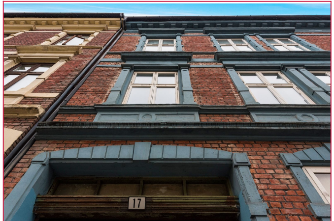
Fasade - Trondheimsveien 17 E.
