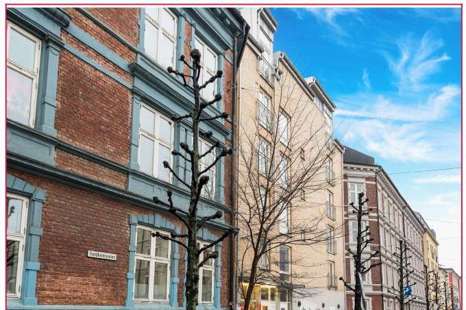
Fasade - Trondheimsveien 17 E.
