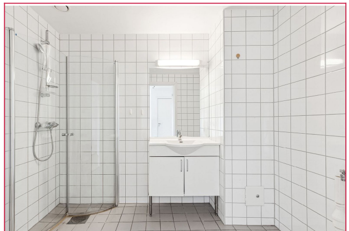
Flislagt bad. Opplegg for vaskemaskin.
