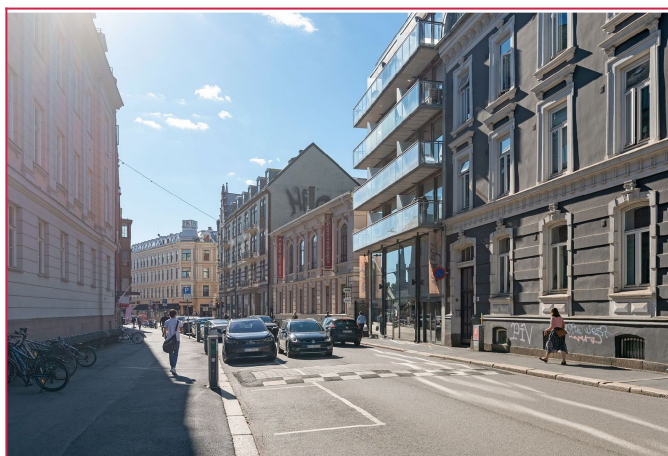
Fasadebilde. Leiligheten ligger i 7. etasje i bygg med glass-balkong.
