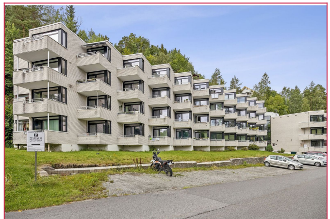
Fasade. Leiligheten er i byggets 2. etasje.
