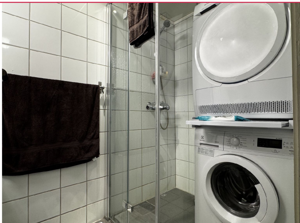
Bad med tørketrommel og vaskemaskin. Oppusset de senere år.
