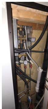
Wather Guard ( vannstoppesystem ) i nisje på soverom.
