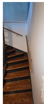
Innvendig tretrapp fra byggeåret.
