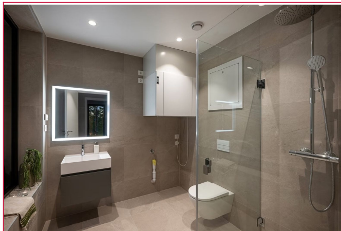
Opplegg til vaskemaskin på baderommet
