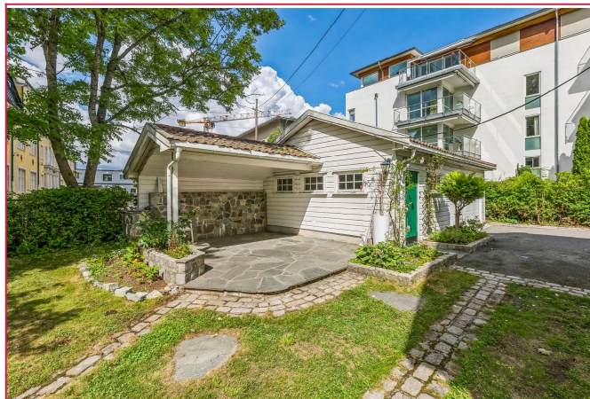
Dobbeltgarasje med overbygget ute plass.
