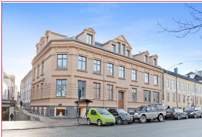
Fasade: Leiligheten ligger i denne flotte bygården med sentral beliggenhet i Fjordgata.
