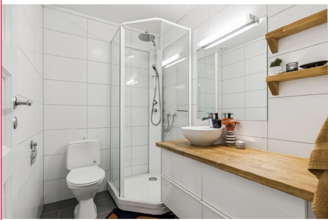
Flislagt bad med varmekabler i gulv.
