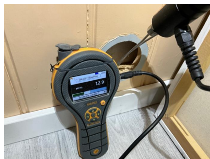
Hulltaking - Fuktmåling - Tørr konstruksjon i hulltakingsområdet på befaringstidspunktet.
