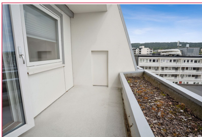
Leiligheten har en egen luftig balkong på ca 5 kvm uten sjenerende innsyn
