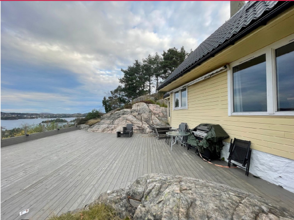
Fasade og terrasse
