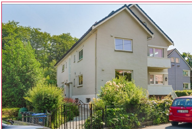
Slettebakkvegen 86 in mot inngangsparti.
