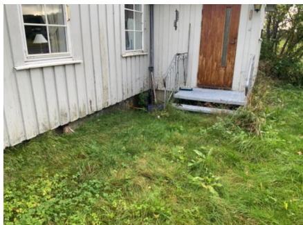
Terrengfall inn mot bygningen.
