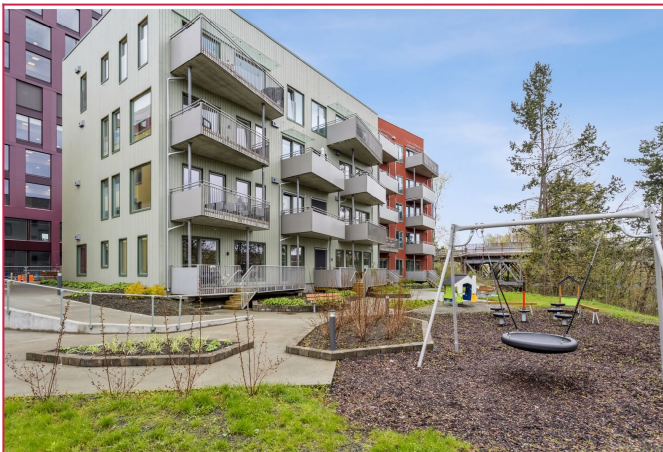
Fellesområde bak blokken. Leiligheten ligger i 1. etasje til venstre.
