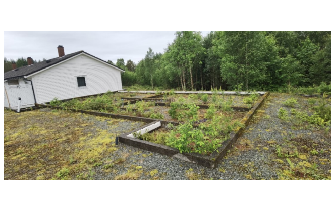
Påstarta arbeid ved fundament, tilbygg til bygningen i aust
