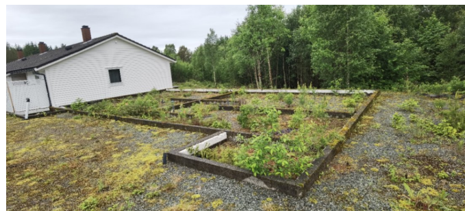
Ringmur aust for eksisterande bygg
