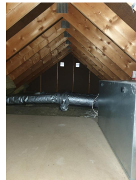
Borettslaget har service avtale på anlegget.
