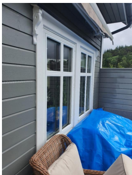
Vindu med utenpåliggende sprosser.
