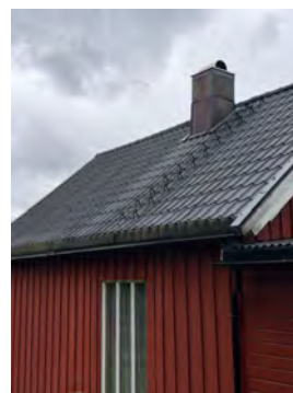
Skjevheter i taket mot vest, tegn til tape mot takplater.
