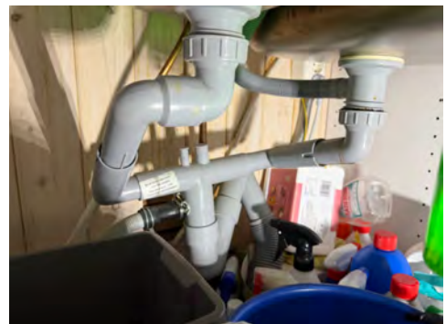
Kontroll av røropplegget.
