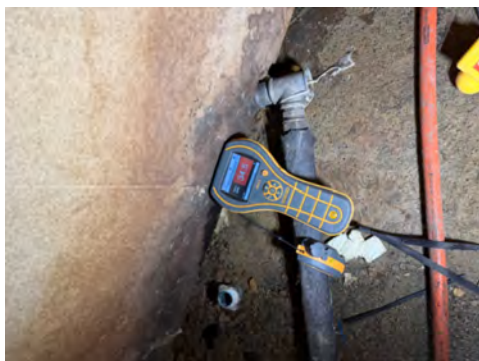
Fukt/råteskader mot veggplater.
