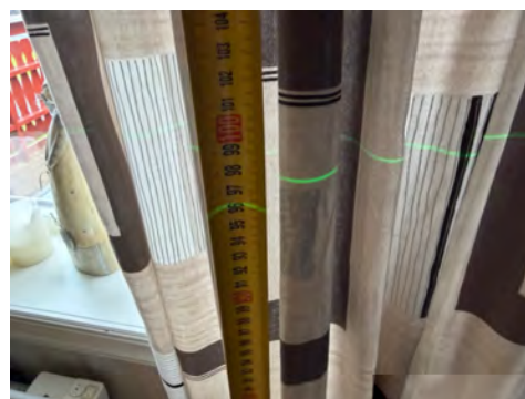
Måling av planavvik gjennom hele rommet, stue.
