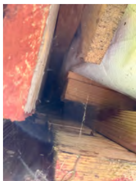
Åpninger bør generelt ikke være større enn 6 mm.
