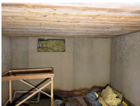
Fukt/råteskader mot veggplater.
