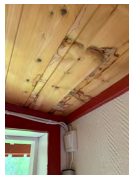
Tegn til råteskader mot taktroen ved raft.
