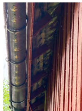
Tegn til råteskader mot taktroen ved raft.
