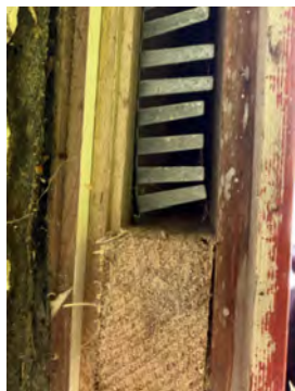
Åpninger bør generelt ikke være større enn 6 mm.
