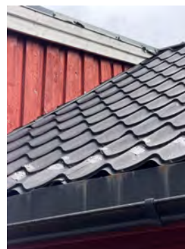
Skjevheter i taket mot vest, tegn til tape mot takplater.
