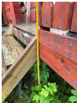
Utvendig trapp mangler rekkverk
