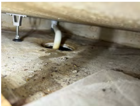
Avtrekk via vifte i vegg.
