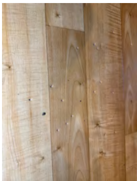
Merker i vinylgulv i loftsetasjen.
