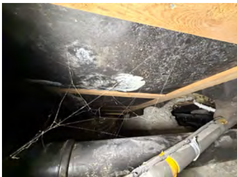
Soppdannelse mot vaflex/papp mot bjelkelag.
