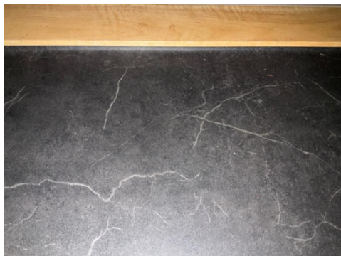
Belegg oppkant ved dør
