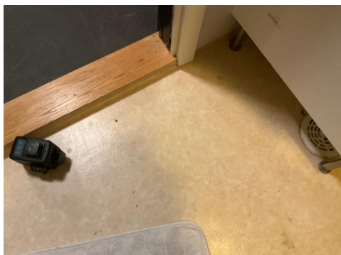
Måling av fall til sluk.
