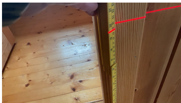
Planavvik ble målt med laser, målt høyde på 49,5 cm
