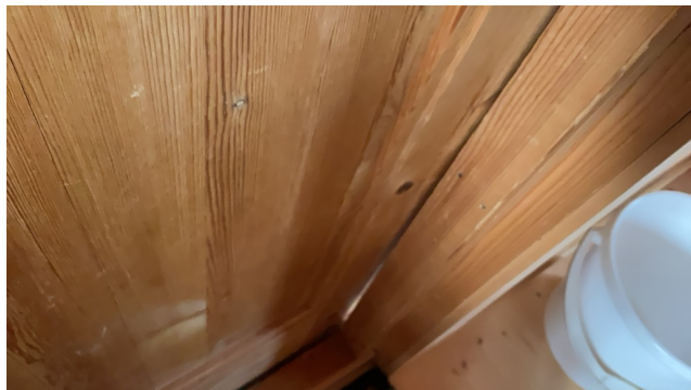
Utettheter på ytterdør overgang karm
