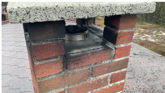
Synlig innerforing av stål i pipe.
