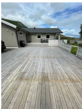
Bildet viser deler av utvendig veranda/ terrasse.
