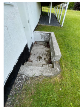
Bildet viser støttemur ved kjellerinngang.
