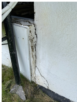
Bildet viser skeivhet i støttemur grunnet marktrykk.
