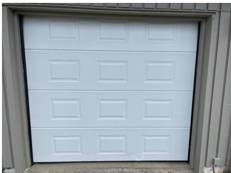
Bildet viser garasjeport.
