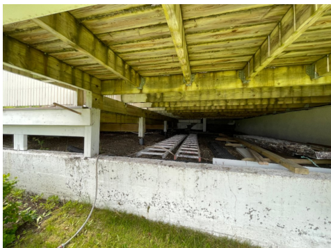
Bildet viser deler av støttemur under veranda/terrasse.
