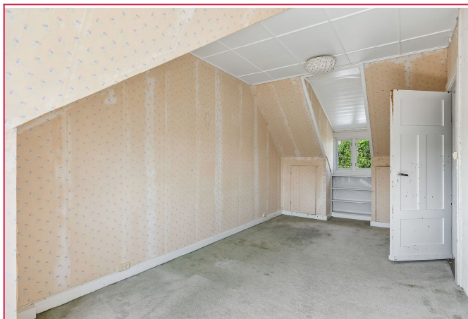
Soverom/bruksrom i 3. etasje. Rommet vil bli oppgradert med maling før overtakelse.
