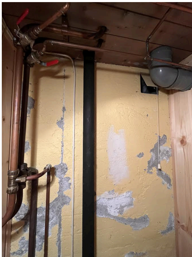
Bilde viser naturlig ventilasjon i ventil i yttervegg.
