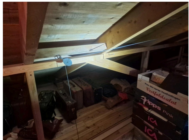
Enkel toppsvill(burde vært 2 stk) som er skjøtet mellom stolper i knevegg.
