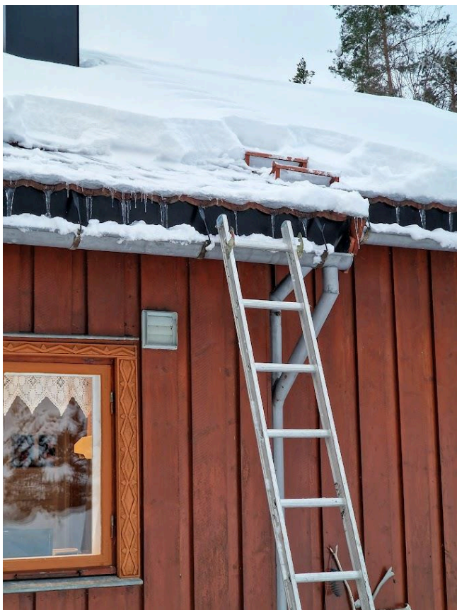
Bilde viser taktrinn opp til pipe.
