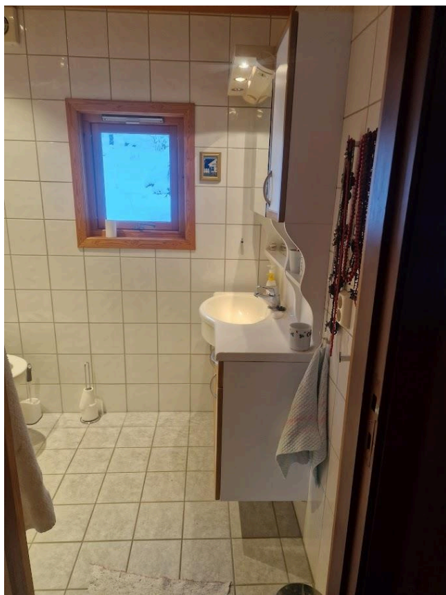
Baderomsinnredning med nedfelt servant med 1-greps baldebatteri.
