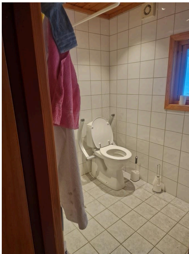
Gulvtoalett med støttehåndtak hvor toalettsskål er ca.0,48m over gulv.
