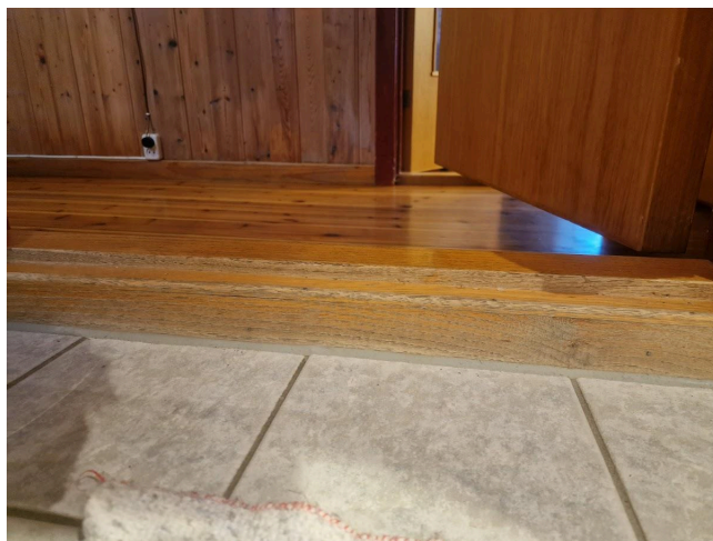
Bilde viser eikelist montert i overgang flis til dørsterskel, elastisk fuge i overgang flis/eikelist.
