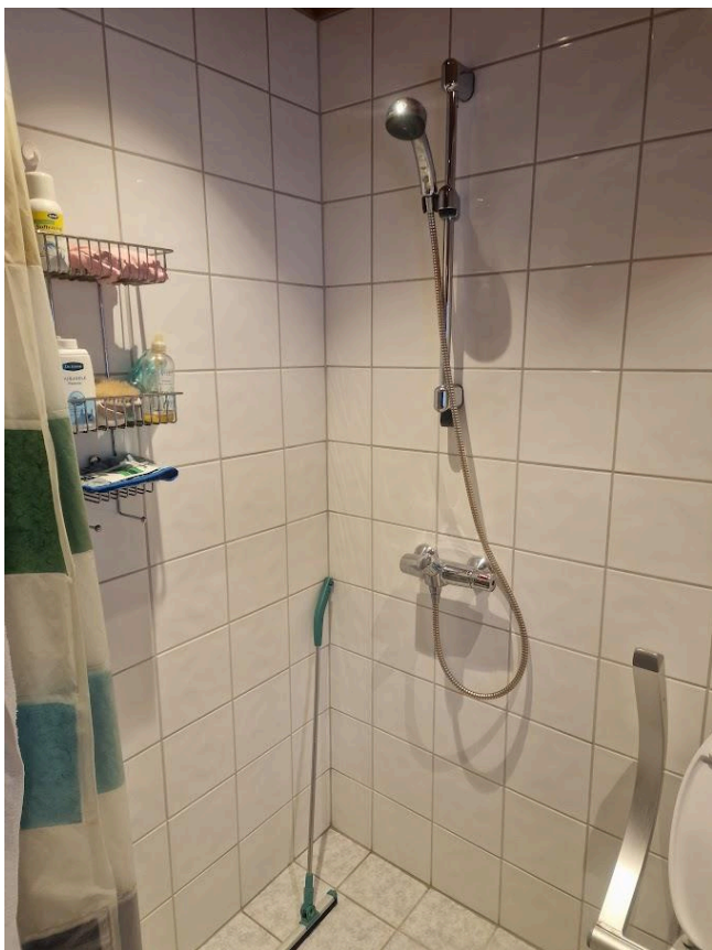
Dusjgarnatyr med temperatur regulerende blandebatteri og dusjforheng.
