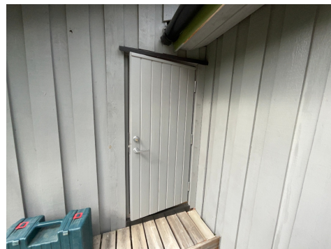
Hovedytterdør/Inngangsdør, mot øst
