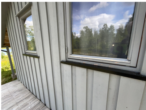
Liten avstand mellom omramming og beslag
