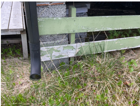
Taknedløp ved søylepunkt
