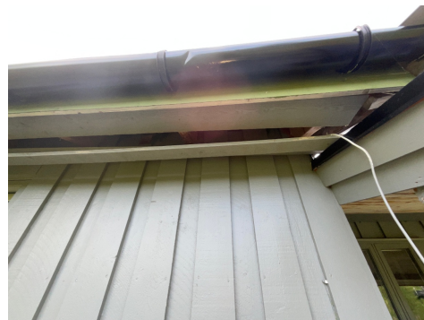
Glenstående arbeider ifbm takkasser, fasade nord
