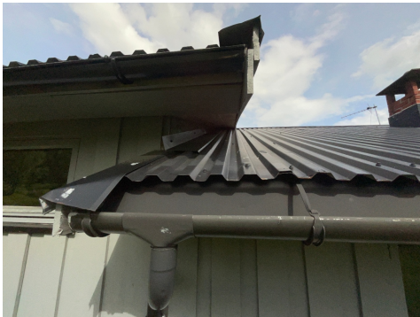
Deformerte beslag
