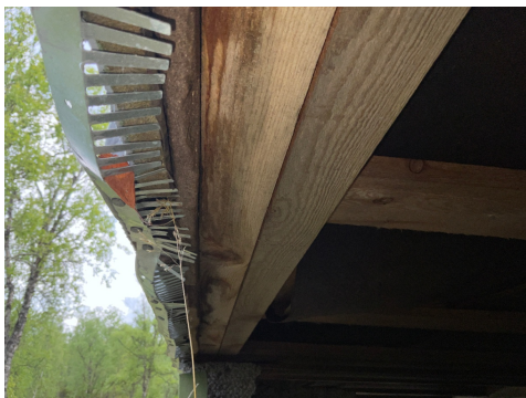
Underkant bordkledning - manglende lufting
