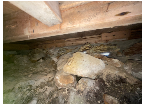
Bilder tatt fra luke i gulv mot kryprom
