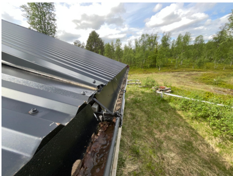
Takfotbeslag mangler delvis i overgang tilbygg
