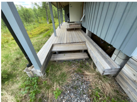
Trapp mot inngang, nord
