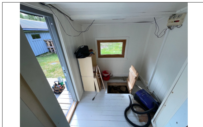
Bolig - vindfang mot sør
