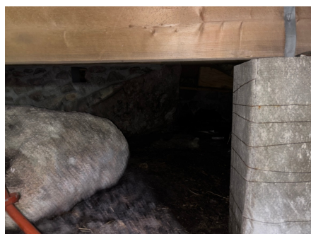
Det er pilarer under hytten
