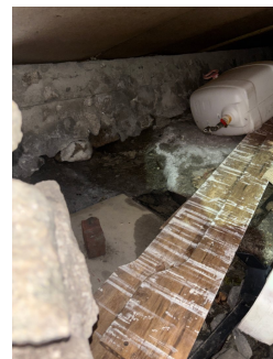
Grunnmuren er med naturstein og betong
