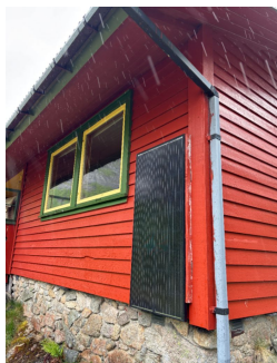
Grunnmuren er med naturstein og betong
