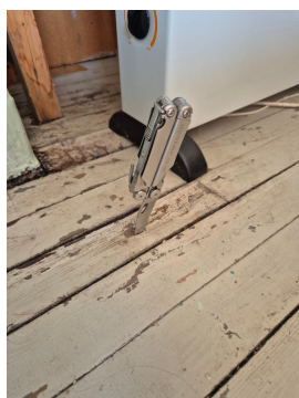
Fukt og råteskade ved pipegjennomføring.
