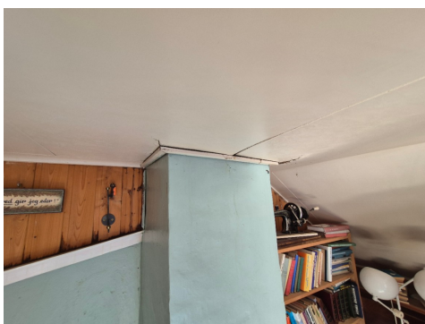
Fukt og råteskade ved pipegjennomføring.
