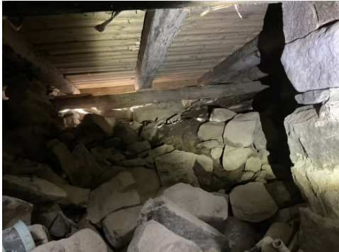
Kryp kjeller med varierende kryphøyder
