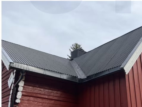
Taktekking med metallplater
