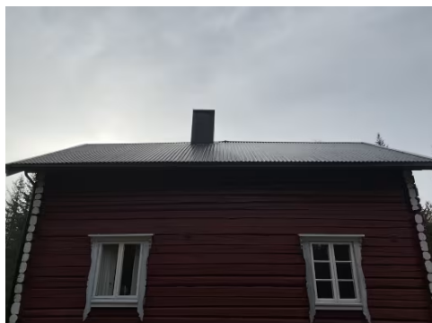
Det er ikke etablert utstyr på tak
