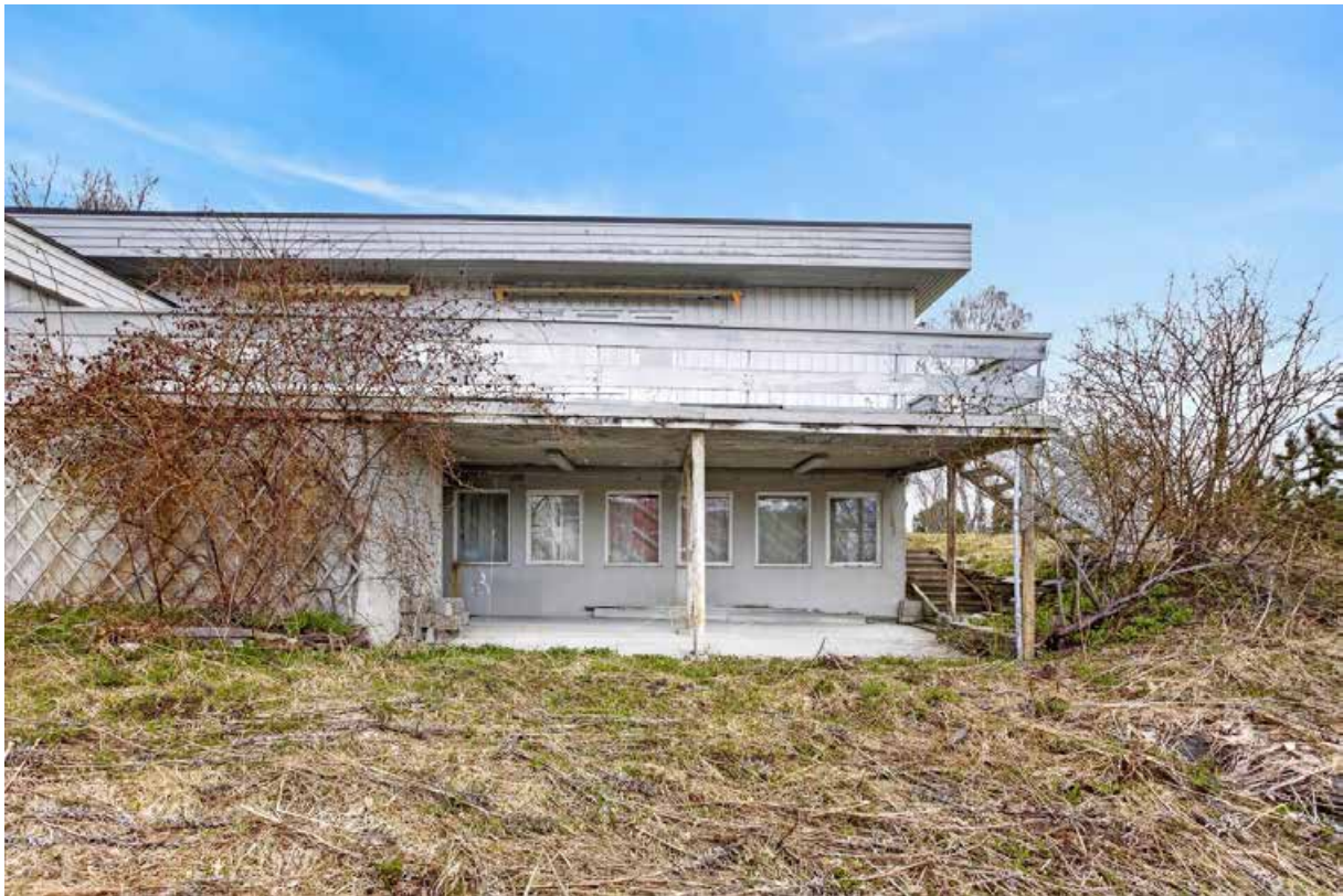
Sydvendt veranda med utsikt mot Harstadbotn, med gode solforhold
