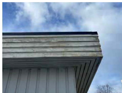
Bildet viser værslitt panel. Vedlikehold og stedvis utskifting må påregnes.
