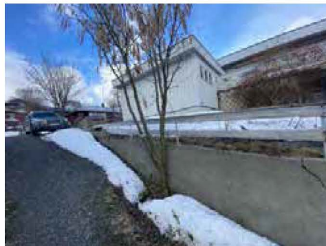
Bildet viser forstøtningsmur i betong.
