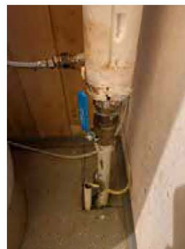
Bildet viser hovedstoppekrane, plassert ved varmtvannstanken i bod i kjeller.
