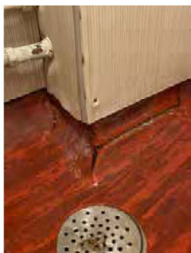
Oversiktsbilde bad/dusjrom med vask i kjeller.
