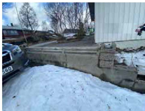
Bildet viser forstøtningsmur i betong.
