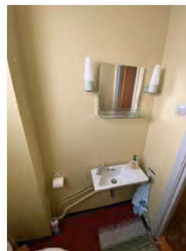
Oversiktsbilde toalettrom, 1. etasje.
