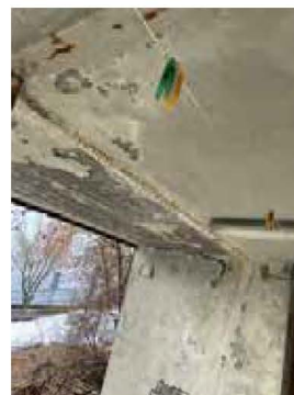
Armeringskorrosjon. Verandaen må påregnes totalrenovert.
