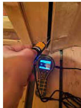
Bildet viser fuktmåling av bad/dusjrom i kjeller.
