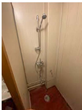
Oversiktsbilde bad/dusjrom med vask i kjeller.
