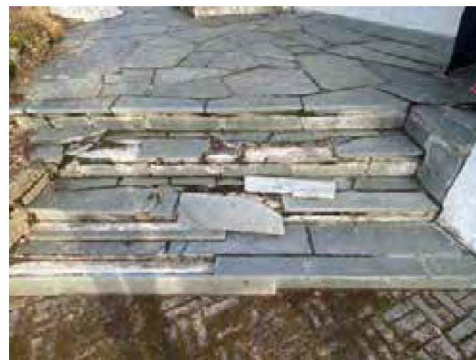
Oversiktsbilde utvendige trapper.
