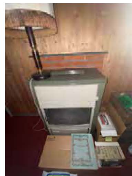
Bildet viser eldre kombiovn olje/parafin i stue i kjeller. Har aldri vært i bruk.
