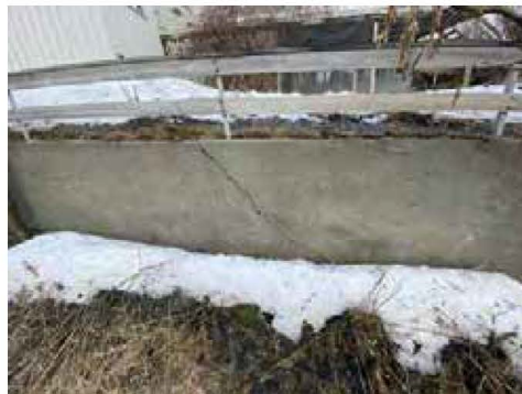
Bildet viser forstøtningsmur i betong.
