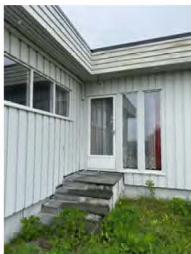
Oversiktsbilde utvendige trapper.
