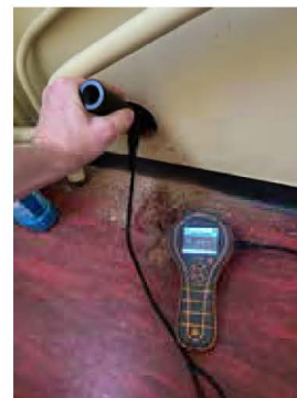
Bildet viser fuktmåling av bad i 1. etg.
