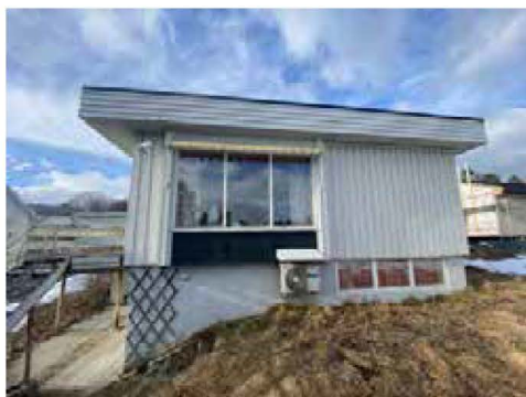
Bildet viser ytterdel til varmepumpe.
