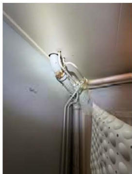
Bildet viser gamle lekkasjemerker på avløpsrør i vaskekjeller.
