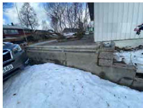
Synlige kabler, ikke fagmessig avsluttet. Kabler er opplyst ikke tilkoblet.
