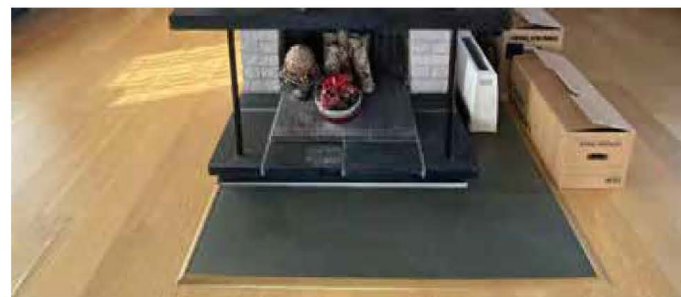
Bildet viser plassmurt teglsteinspis i stuen i 1. etasje.
