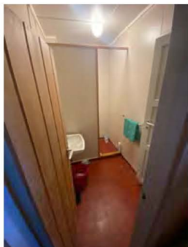
Oversiktsbilde bad/dusjrom med vask i kjeller.
