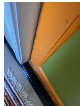
Bilde viser knip i dør med funksjonssvikt.
