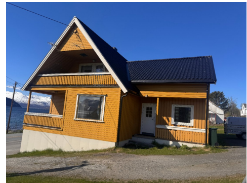
Bilde viser takteking i overgang eldste del og tilbygget del.
