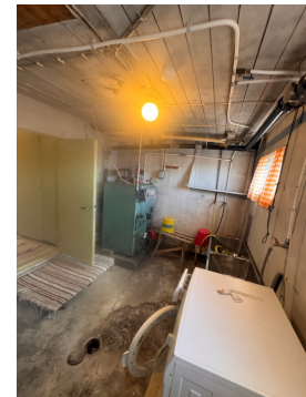
Bilde viser vaskerom vendt mot adkomst til gang/trapperom og boder.
