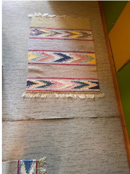
Bilde viser gliupe i åpning for belegg på loft.
