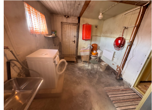
Bilde viser vaskerom i kjeller med utgang marknivå.
