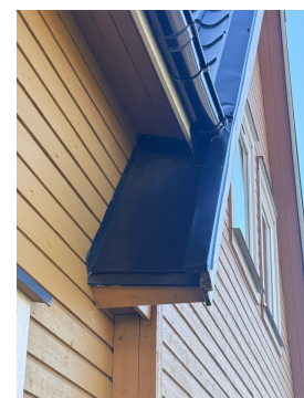
Bilde viser tilpasning med bulk lokalt på vindskibord av aluminium.
