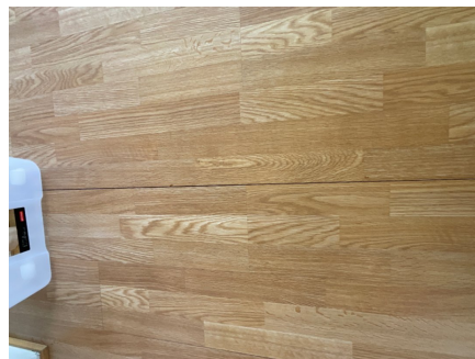
Glippe i laminatgulv i stue.
