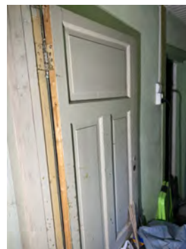
Dører i kjeller fra byggeår i kjeller.
