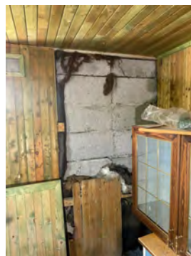
Synlig mur av lettklinkerblokker.
