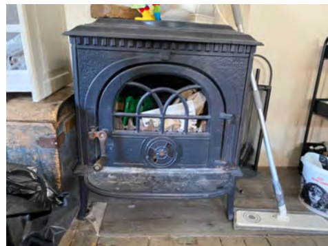
Vedovn plassert i stuen
