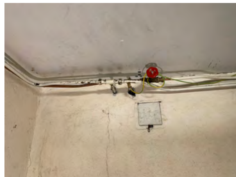
Levetid- Vannrør av kobber over 25 år - "Mer enn halvparten av forventet brukstid er oppbrukt" = TG 2
