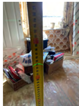
Planavvik innenfor 2. meter i loftsetasjen.
