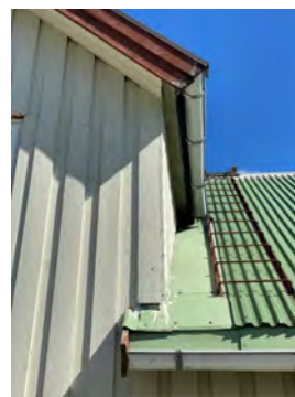
Rust i takstige, manglende bue over pipehatt.
