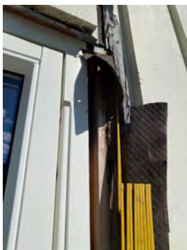
Påbegynte råteskader i konstruksjon.
