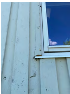
Påbegynte råteskader i konstruksjon.
