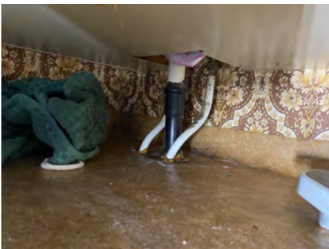
Rørgjennomføringer i gulv.
