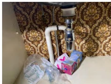
Rørøpplagg under servant.
