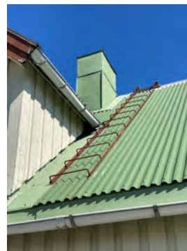
Rust i takstige, manglende bue over pipehatt.
