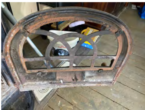
Manglende glass/pakning på dør til vedovn
