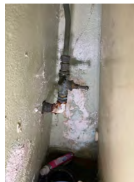
Levetid- Vannrør av kobber over 25 år - "Mer enn halvparten av forventet brukstid er oppbrukt" = TG 2
