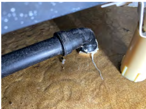
Avløp fra dusjkabinett.
