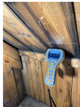
Fuktmåling i takkonstruksjon viste ingen forhøyede fuktverdier.
