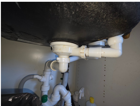
sprekk/lekkasje ved PVC-kobling under oppvaskkum
