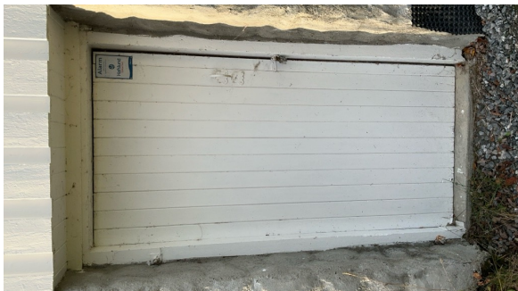
Kjellerdør i heltre fra byggeår.
