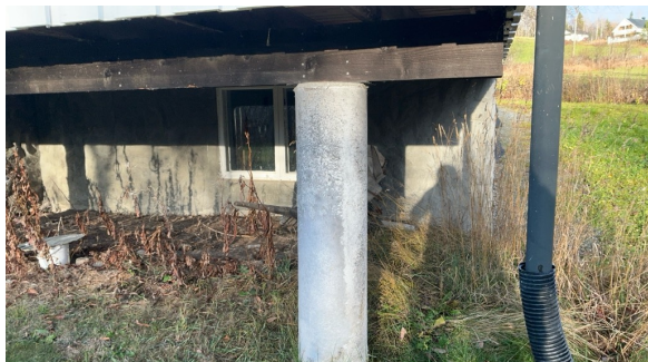
Fundamentering med betongpillar/søyle.
