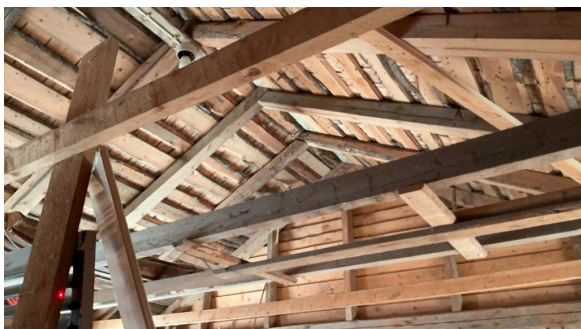
Takkonstruksjon på tilbygget bod.
