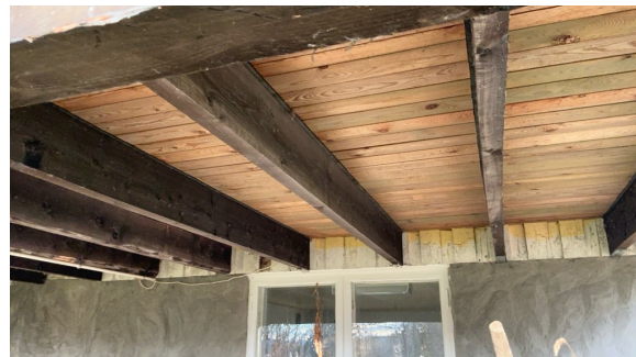
Bjelkelag med innfesting mot vegg (uisolert)
