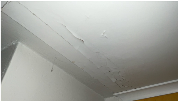
Flassing på overflater ved pipe på loftetasje.
