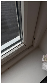
Spør etter innvendig kondensering av på vindu.
