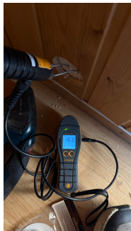
Fuktmåling i bunnsvill via hulltaking
