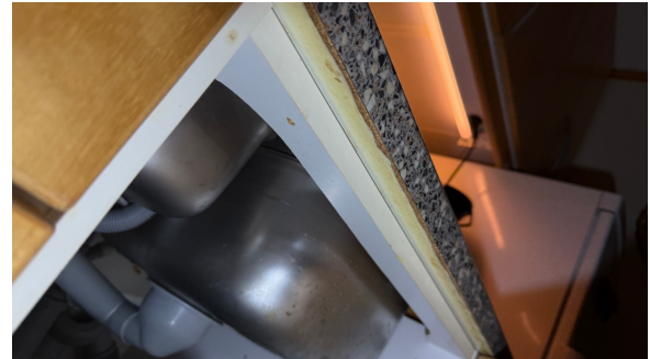
Svelling i underkant av benkeplate.
