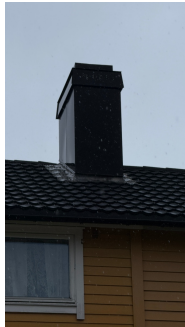
Beslag rundt pipehatt, inspisert fra bakkenivå.
