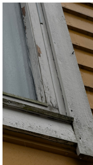
Spør etter innvendig kondensering av på vindu.
