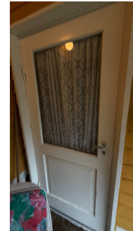
Kjellerdør i tre med glass. Værslitt
