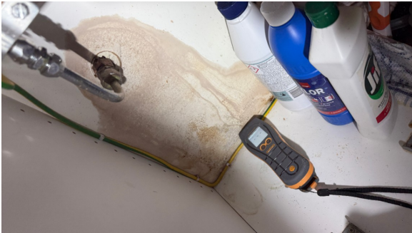
Fuktskjold på vegg i benkeskap under vask. Det ble ikke registrert forhøyet måling av fukt ved stikkprøve med fuktmåler på befaringsdagen.
