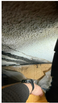
Avrenning fra sotluken på pipe i kjeller. Manglende ildfastplate under sotluken.
