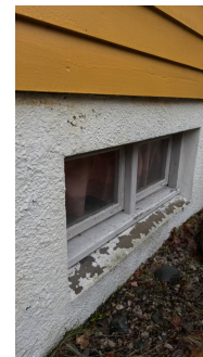
Vinduer er montert direkte i mur- eller betongvegg uten underliggende beslag.
