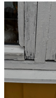
Vinduer er montert direkte i mur- eller betongvegg uten underliggende beslag.
