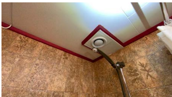
Avtrekk i tak.
