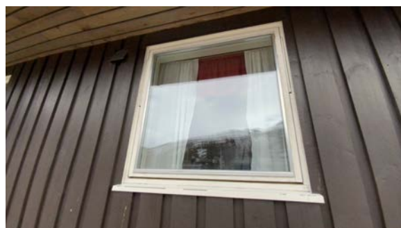
Omramming står nede på vindubeslag
