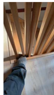
For stor åpning under nederste trinn
