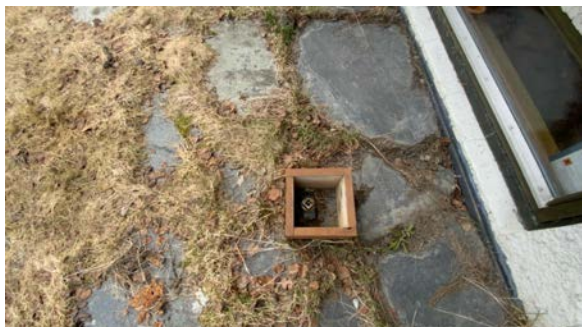
Utvendig stoppekrane
