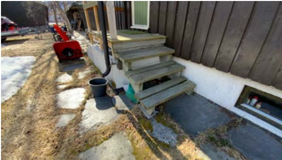
Mangler rekkverk.
