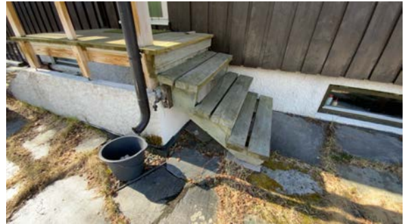
Trappevanger står på terreng.
