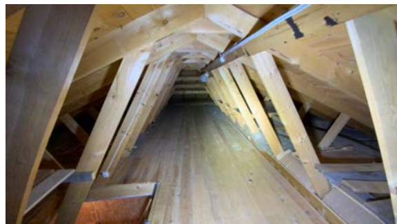
Gulv på deler av kaldloftet
