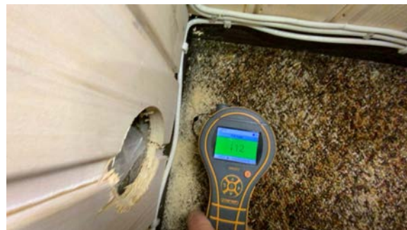
Ikke påvist skadelig fukt i gulv i kjellerstue
