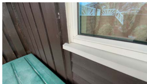
Omramming helt nede på vannbrett
