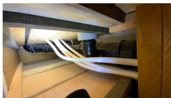
Vann og avløpsledninger inkasset på bad i kjeller
