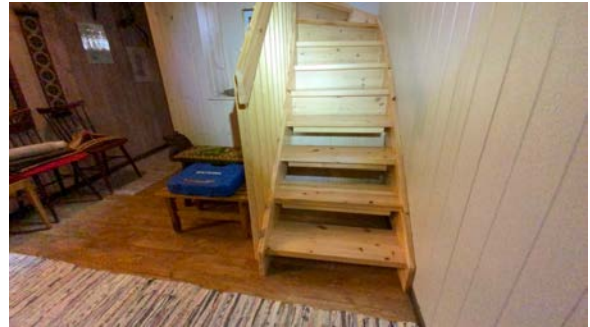
For stor åpning under nederste trinn
