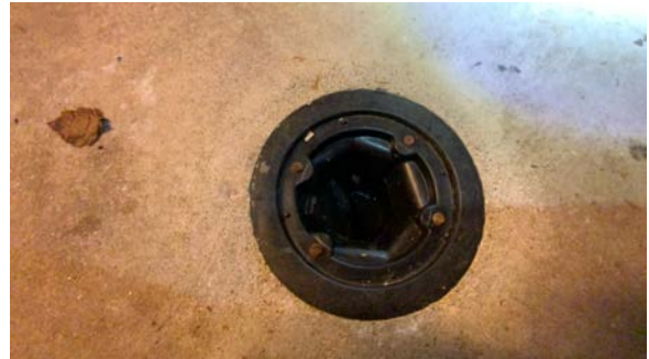
Sluk, rust på skruer
