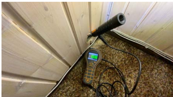
Ikke påvist skadelig fukt i kjellerstue.
