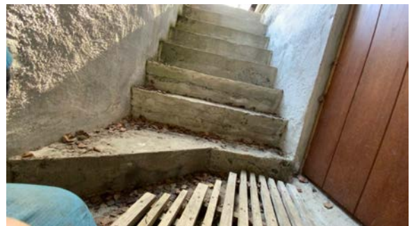
Forskjellige trinnhøyder, målt 19-21 cm
