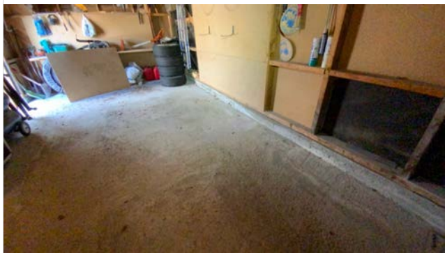
Ringmur i betong/leca.
