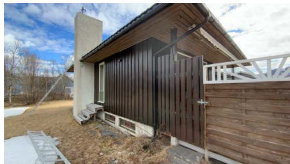
Takrennenedløp avsluttes over bakkenivå
