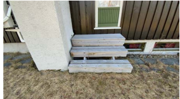
Mangler rekkverk
