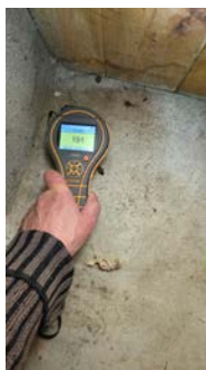
Fuktsøk på gulv, ikke registrert skadelig fukt
