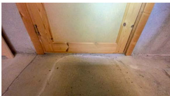
Tett ved dør.
