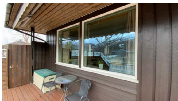
Stuevinduer skifte i 2014
