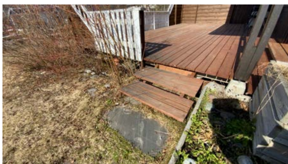
Trapp til terrasse.
