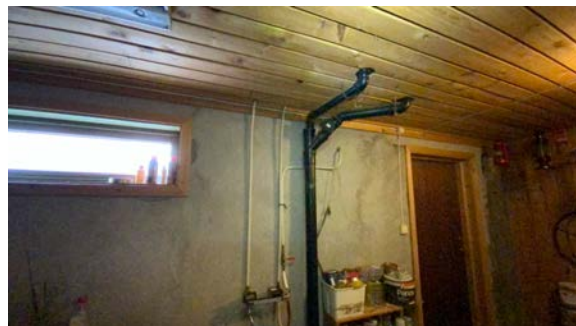
Avløpsrør i plast
