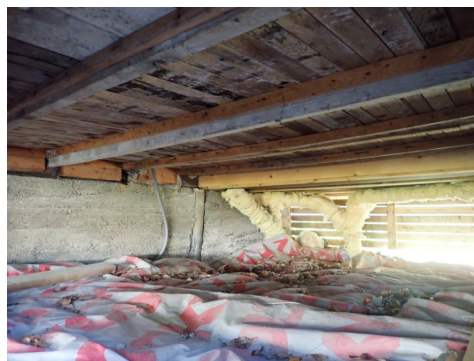
Kryprom under vf og bad
