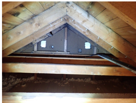
God lufting av kvistrom med 2 ventiler i hver røstvegg
