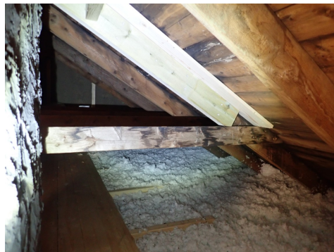
Forsterket en råteskadet sperre
